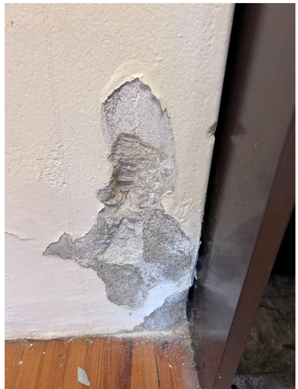
Bilde 17: Puss på pipe, prøve A12
