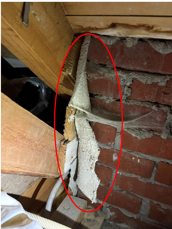
Bilde 2: Skorsteinspapp med påvist asbest i loftet
