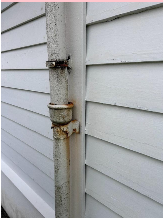
Bilde 4: Antatt asbestpakning under blyskjøt
