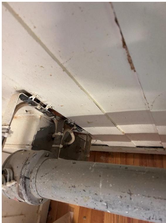
Bilde 3: Antatt asbest i radiatorventil tilkoblet varmeanlegg
